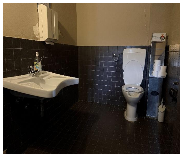
38 toilet and toilet
